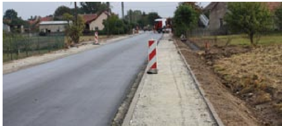
Budowa obustronnych chodników we wsi Kaszyce Wielkie
