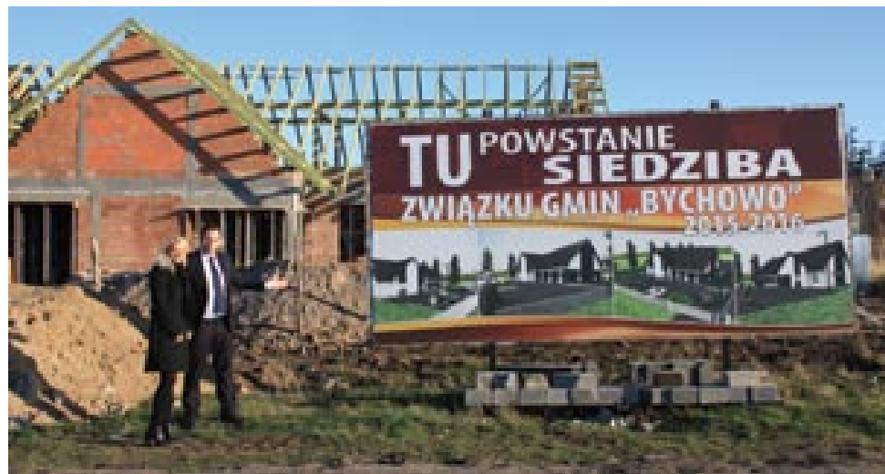
Burmistrz Igor Bandrowicz i Radna Powiatu Trzebnickiego Marzanna Jurzysta – Ziętek przy powstającym, nowoczesnym obiekcie Związku Gmin Bychowo i Zakładu Wodociągowego ZGB
