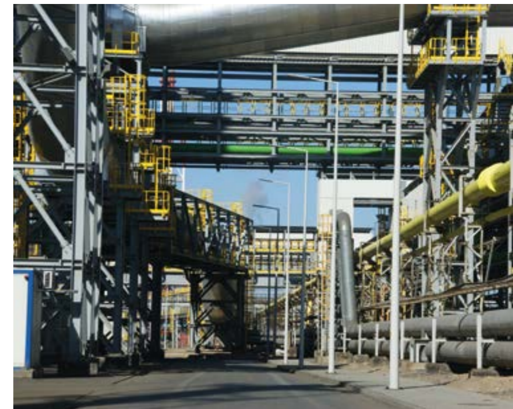
HM Głogów - Estakady Energetyczne
